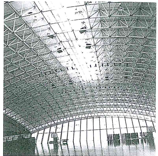
Bild 14. Sporthalle in Oguni/Japan, Raumfachwerk mit Spannweiten von 63,5 m x 47,0 m
