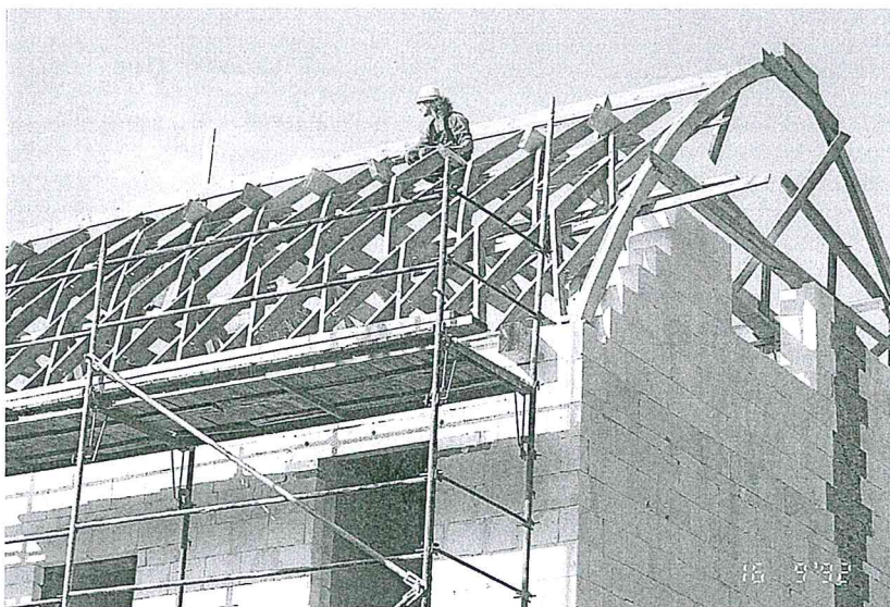
Bild 5. Gebäudeaufstockung in Merseburg/Sachsen-Anhalt unter Verwendung einer historischen Holzbauinnovation der 20er Jahre der Zollbau-Lamellen-Bauweise
