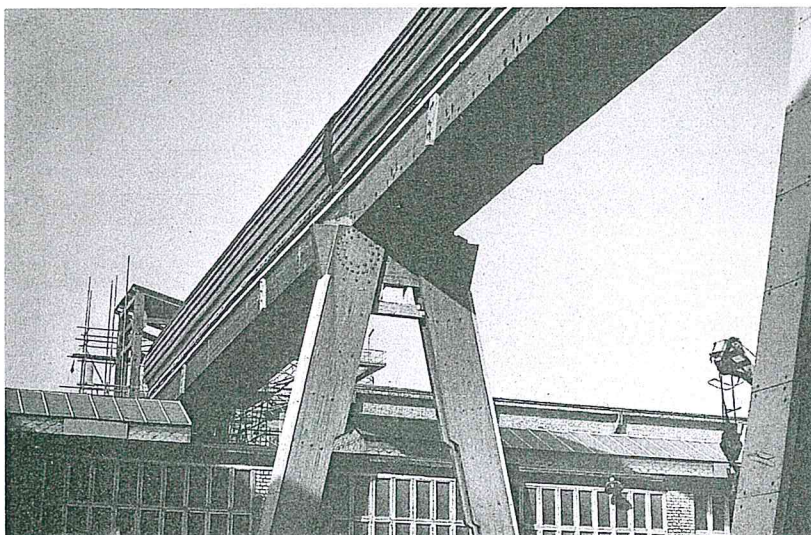
Bild 18. Industrie-Förderbrücke in Brettschichtholz
