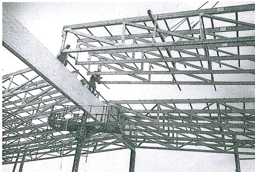
Bild 7. Montage einer Nagelplatten-Fachwerkbinder-Konstruktion
